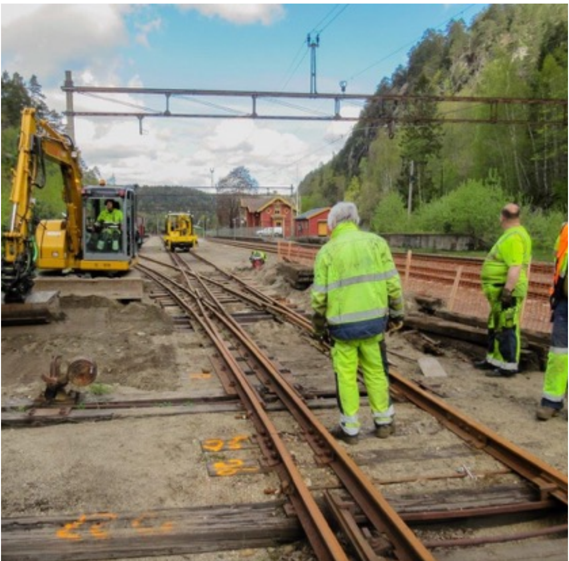
Skifting av vekselviller på Grovane. Foto: Jack Nielsen.
